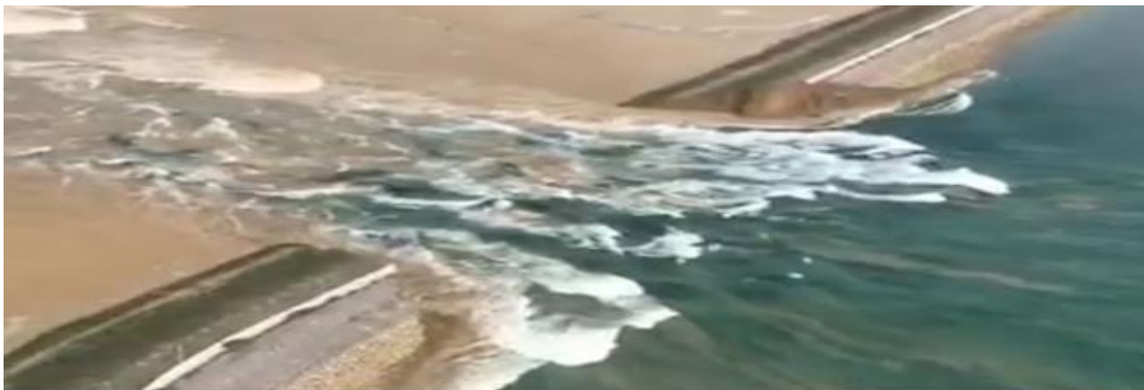
2-rasm. Sardoba suv ombori buzilishi.
